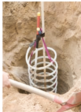
Rys. 9: Wprowadzanie sondy RAUGEO Helix PE-Xa do otworu wiertniczego
