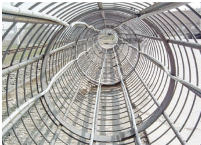
Rys. 81: Kolumna geotermalna - ułożenie rur
