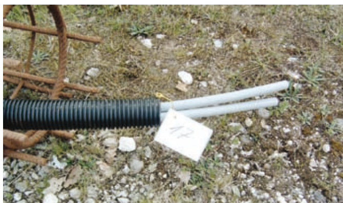
Rys. 84: Zabezpieczenie zasilania i powrotu w rurze ochronnej
