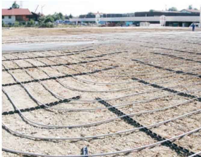
Rys. 14: Kolektor RAUGEO PE-Xa na placu budowy
