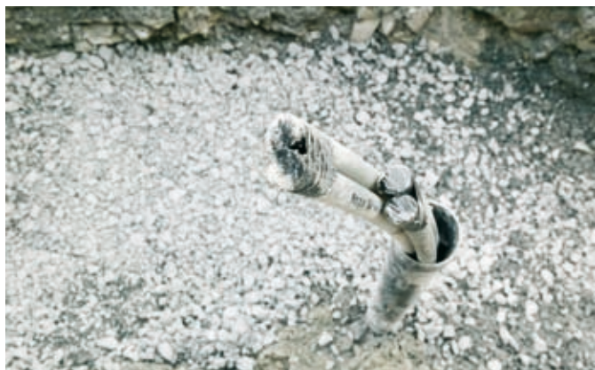
Rys. 74: Zalanie otworu wypełnieniem
