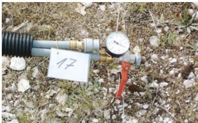
Rys. 85: Przymocowanie urządzenia do próby ciśnieniowej
