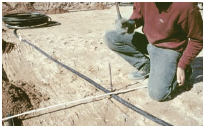
Rys. 67: Układanie rur i mocowanie
