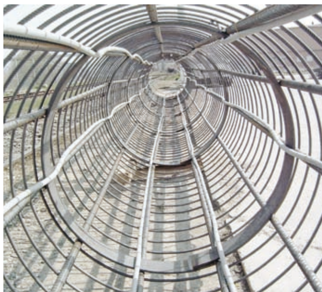
Rys. 19: Kolumna RAUGEO - widok od środka pala fundamentowego
