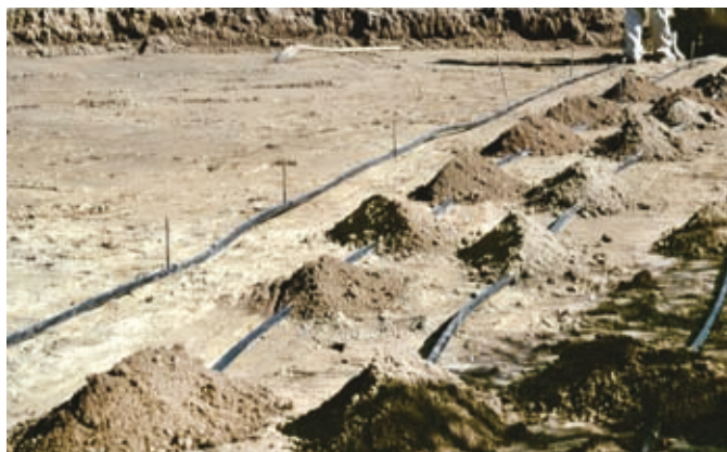
Rys. 68: Przykrycie rur ziemią lub piaskiem
