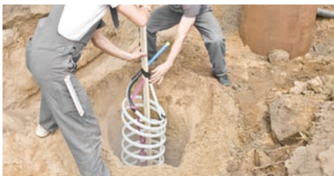
Rys. 78: Umieszczanie sondy w otworze
