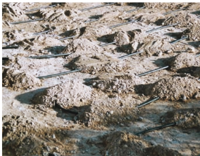
Rys. 16: Kolektor RAUGEO PE 100
