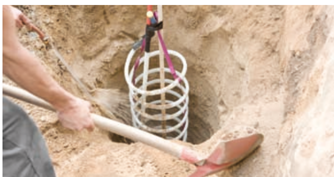
Rys. 79: Wypełnienie wywierconego otworu
