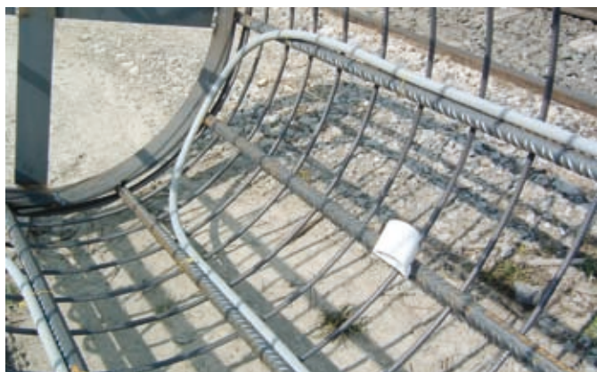
Rys. 83: Przymocowanie rury do kolumny zbrojeniowej
