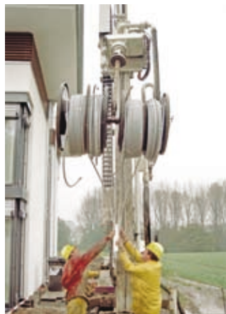
Rys. 5: Wprowadzanie sondy RAUGEO PE-Xa do otworu wiertniczego
