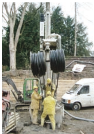
Rys. 11: Wprowadzanie sondy RAUGEO PE 100 do otworu wiertniczego
