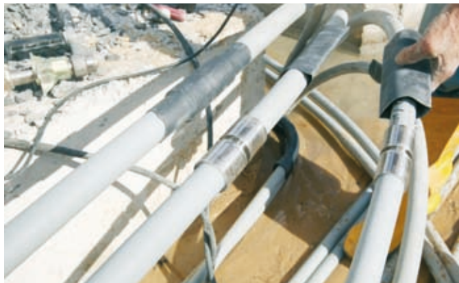
Rys. 75: Podłączenie sondy do przewodów zasilających
