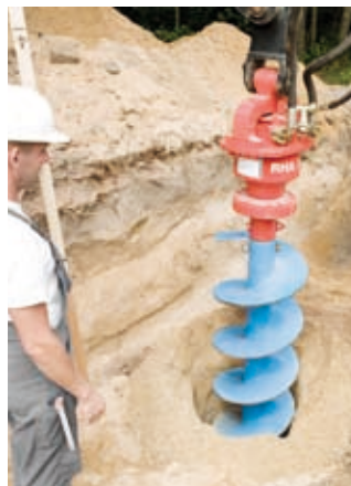
Rys. 8: Wiercenie świdrem otworu pod sondę Helix
